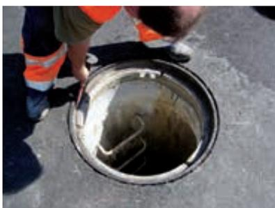
15. Reinigen des Schachthalses und der Aussparungen im Gussrahmen (z.B. Aussparungen für Drehsicherungen). Fließmörtel bei normalen Verhältnissen ca. 2 Stunden erhärten lassen.
