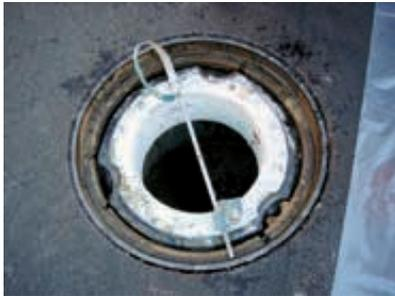
12. Einsetzen der Schlauchschalung (Fig. 3280).
