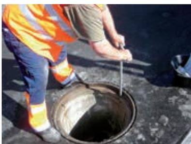
16. Gleichmässiges Anziehen der 3 Stellschrauben bis diese fest sitzen (sehr wichtig). Reinigen der Sitzflächen von Rahmen und Deckel. Nochmaliges Einfetten der Stellschraubenköpfe und Aufsetzen der Plastikklappen.
