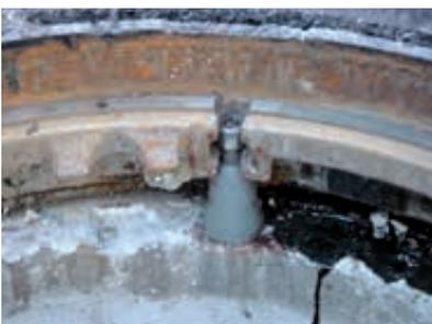
11. Anbringen der Schaumstoffhülsen Art. 867017 um die Gewinde der Stellschrauben.
