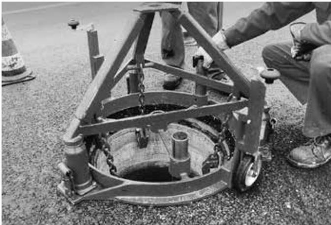
Hochziehen des Rahmens mittels hydraulischen Pressen
