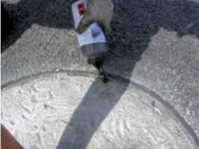
17. Füllen des Spaltes zwischen Rahmen und Belag mit 2-Komponenten-Schachtrahmen-Giessharz, Art. 913084 oder bituminöser Vergussmasse KBH.
