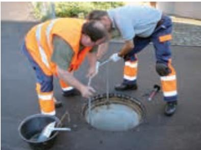
9. Anpassen des Gussrahmens mittels der 3 Stellschrauben auf die Höhe Deckschicht. Schrauben abwechselnd gegen den Uhrzeigersinn drehen.
