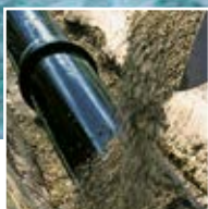
Быстрая и экономичная прокладка трубопроводов
